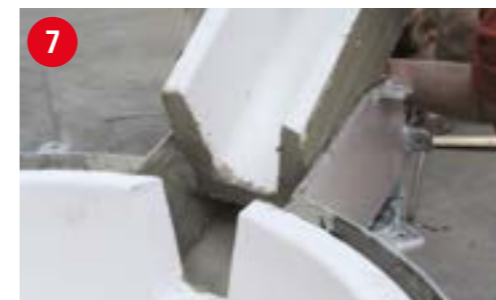
7 Auch die Stahlform im Gießschnauzenbereich wurde vollflächig mit INSURAL 800 bestrichen
