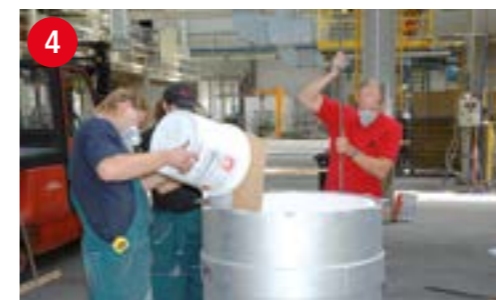
4 Einfüllen der Ausgleichsmasse INSURAL 10 in den Zwischenraum von ATL und Stahlmantel
