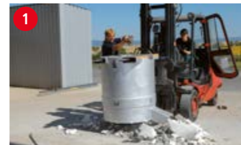
1 Einfaches Entleeren der alten Auskleidung
