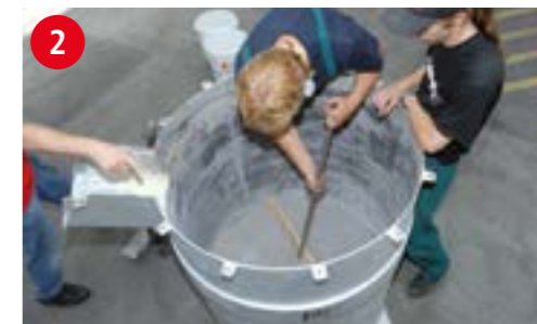
2 Der gesäuberte Stahlmantel ist bereit für die Neuzustellung
